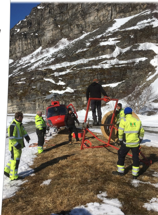
Fiberbygging mellom Kokelv og Snefjord. Her brukte vi helikopter til utflyging av fiberkabelen.
