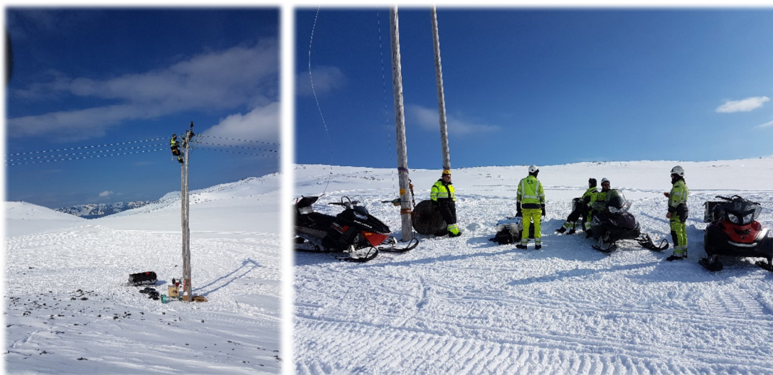
Trådkifte på 22 kv-linjen til Kjelvik.
