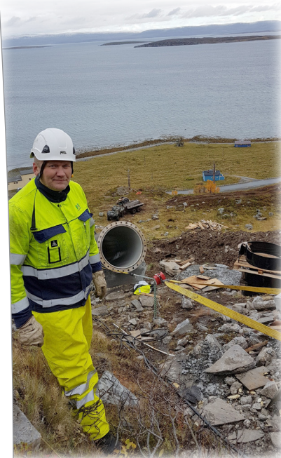
88 meter av rørgata skiftes ut etter raset 5. mai 2017. T.v. Victor Jensen, leder produksjon.
