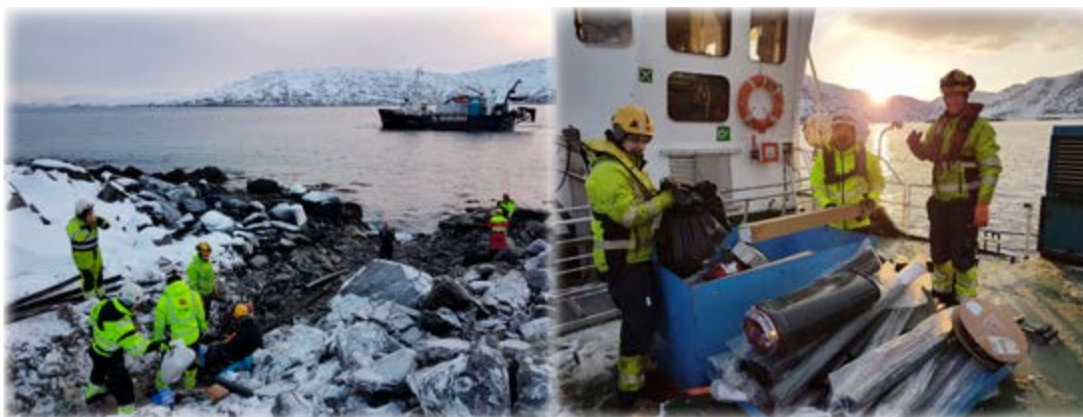
Reparasjon av sjøkabelen til Måsøya.
