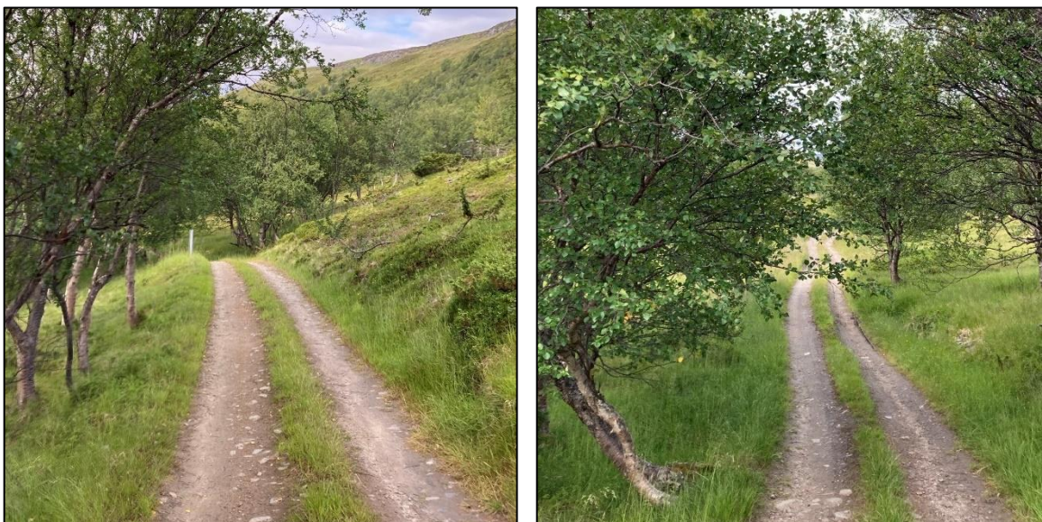
Figur 2-5. Bilder fra vegstrekning vest for Tverrelva. Vegen er stedvis smal og må utvides noe, samt rydding av noe vegetasjon langs vegkanten. Toppmasser vil lagres til revegetering av vegskjæringer. Foto: Sweco.
