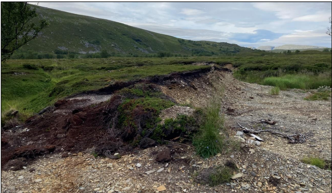
Figur 2-17. Eksisterende masseuttak, tatt mot vest. Topplaget skal fjernes skånsomt og mellomlagres på anvist plass for gjenbruk til revegeteringstiltak. Foto: Sweco.
