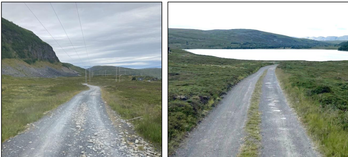
Figur 2-3. Bilder av veien mellom avkjøring fra E69 og frem til Strandvatnet (t.h.). Veien er i god stand, og kun grusing av eksisterende veibane vil gjennomføres for å styrke veien ytterligere. Foto: Sweco.
