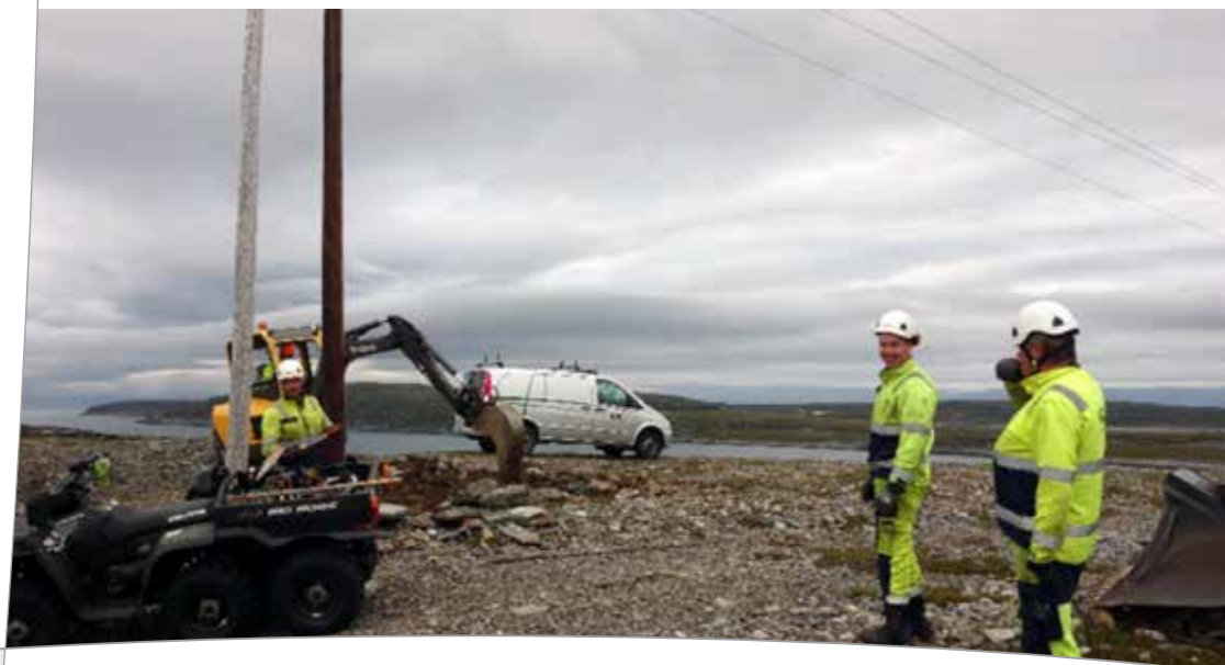
Stolpeskifte på Repvåglinja
