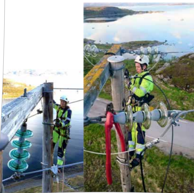
Lærling Sigrid Jørgensen i arbeid på 66 kV linjen.
