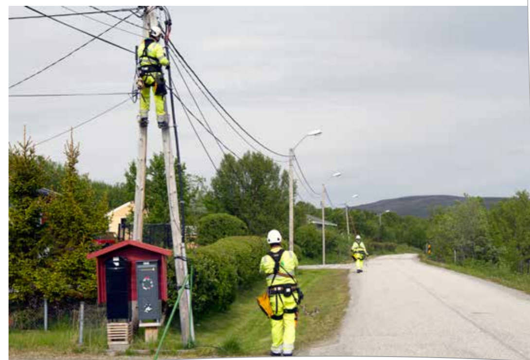
Montører i gang med fiberutbygging i Olderfjord.
