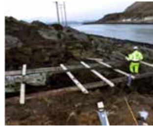
Klargjøring for skjøting av 66 kV kabel ved Havøysund etter graveskade.
