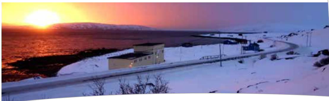
Repvåg kraftstasjon sett mot nord. Velferdshytta vår i bakgrunn
