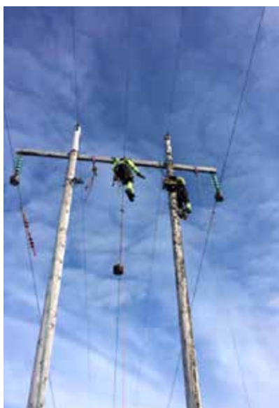
Arbeid på 66 kV linje vest Smørfjord - Storbukt.
