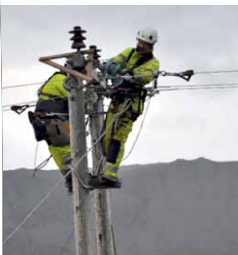
Lærling Sigrid Jørgensen i arbeid på Gjesværlinja. Montør Stig Olav Bårdsnes i bakgrunnen.
