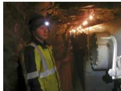
Arbeid i rørtunnelen Repvåg Kraftverk. Inspeksjon av rørkolaps sikring. Lærling Eirik Albertsen.
