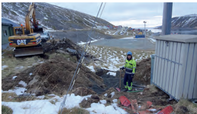
John Runar Jensen i arbeid på kabelprosjekt i Nordvågen.
