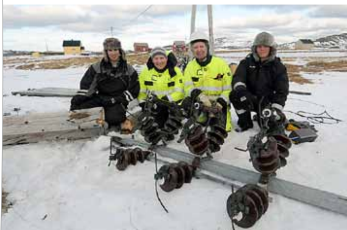
Fjerning av linjer på Ingøy til fordel for kabelanlegg.
